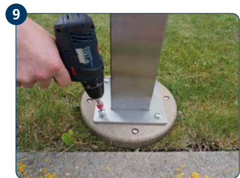
9 Endgeräte (Ladesäule, Steckdosenleiste, Standleuchten) montieren.
