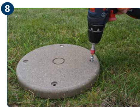
8 ETGAR Trägerplatte aufsetzen und über mitgelieferte Schrauben fixieren.
