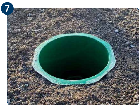
7 ETGAR Fundament-Box abschließend verfüllen.
